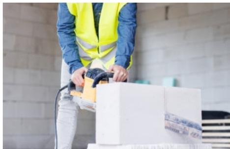
Der **SAFETY BLOC 120** kann per Hand oder mit einer Elektrosäge auf das gewünschte Maß zugeschnitten werden.
