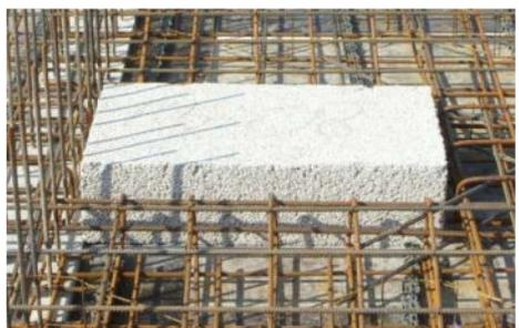
Bei der Verlegung vom **SAFETY BLOC 120** darf kein Schalungsöl verwendet werden, da ansonsten die Haftung mit dem Beton nicht mehr gegeben ist.
